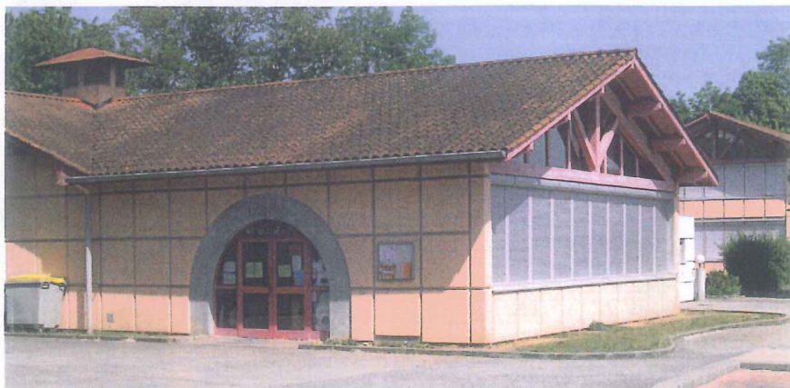
Groupe scolaire primaire de Villieu
