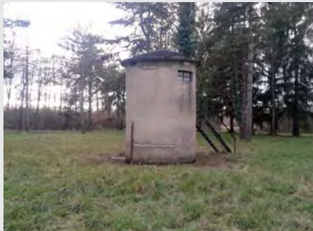
Puit de captage de Villieu
