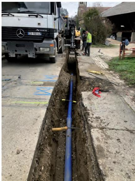
Ces travaux consistaient à remplacer la colonne d'eau, de la rue des Sources jusqu'au réservoir de Fétan et la reprise de la connexion de chaque habitation dont le branchement était encore en plomb.
