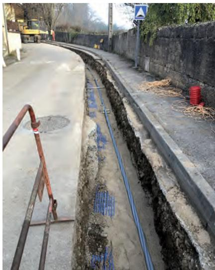
Ils consistaient à basculer les branchements de la colonne de  $\varnothing 80$  mm sur celle de  $\varnothing 150$  mm qui servira également à l'alimentation du futur château d'eau, du lotissement Les Grandes Terres jusqu'au chemin de Chantagry, route de Châtillon. Nous en avons profité pour remplacer les bornes incendie devenues obsolètes.
