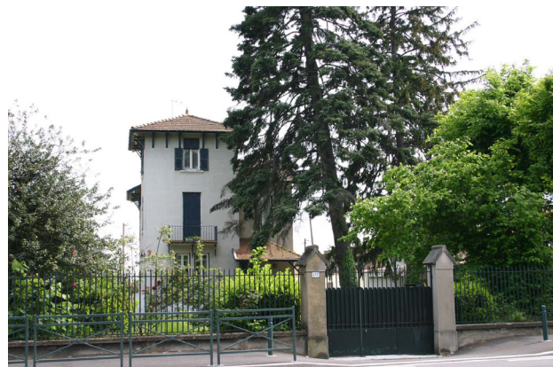
Maison à l'architecture néo florentine.
