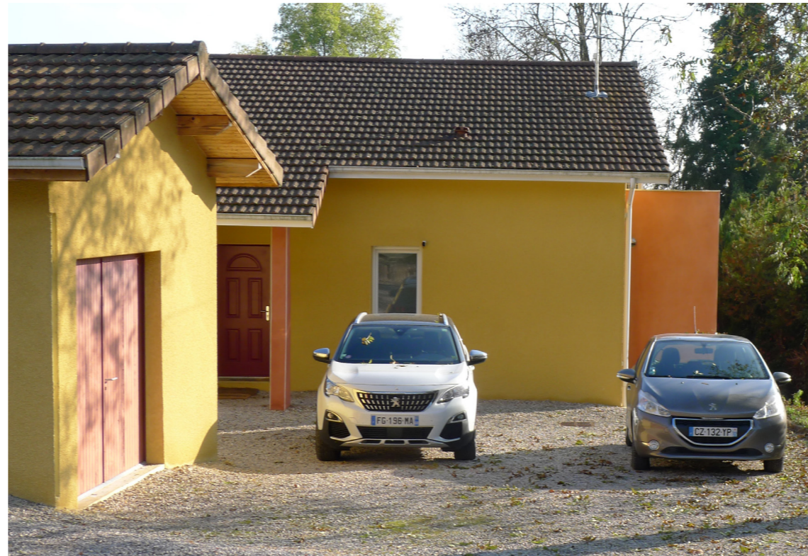
Teintes trop vives et variées sur un même bâtiment
