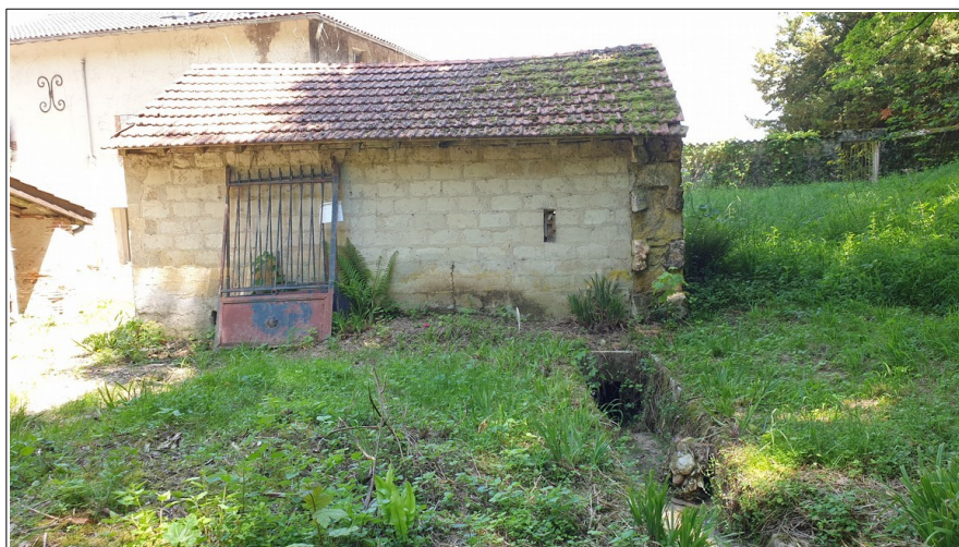
Figure II.4: ruisseau du Château de Boissieu busé à l'amont du village de Varambon.
