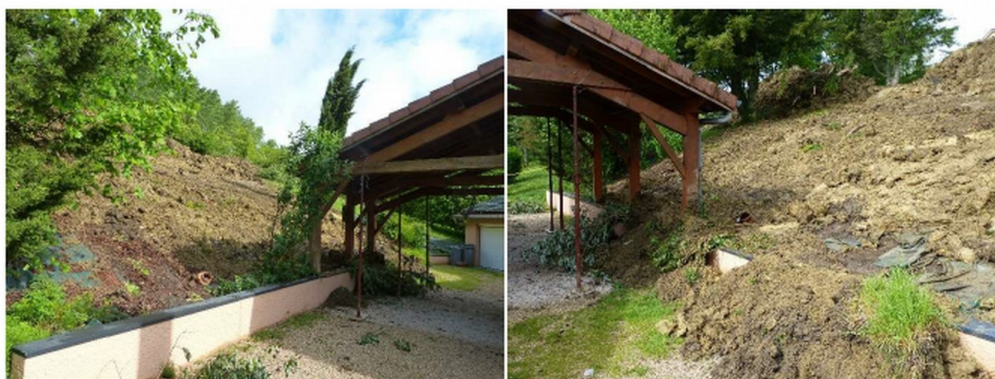
FIGURE 10 : SUPPRESSION DE LA LANGUE PROPAGÉE DE PIED DE GLISSEMENT DANS LE TALUS AVAL PAR TERRASSEMENT A LA PELLE
