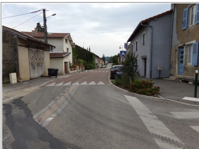
Figure III.48: Croisement entre la montée de Trévouge et la RD 984 où peuvent se propager les débordements du ruisseau.
