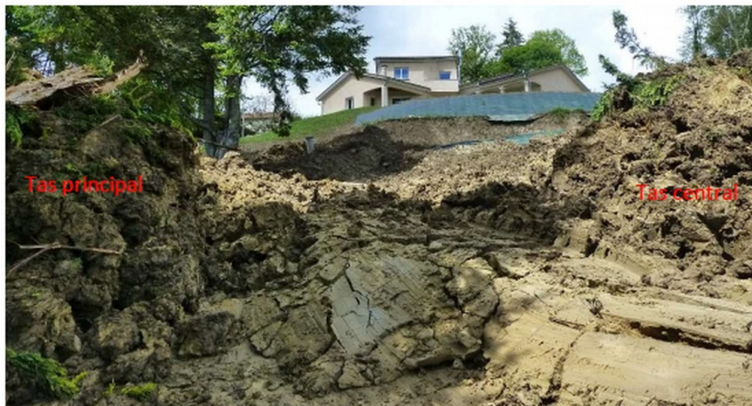
FIGURE 14 : ESPACEMENT LAISSE ENTRE LE TAS PRINCIPAL ET CENTRAL POUR ÉVACUATION DES EAUX
