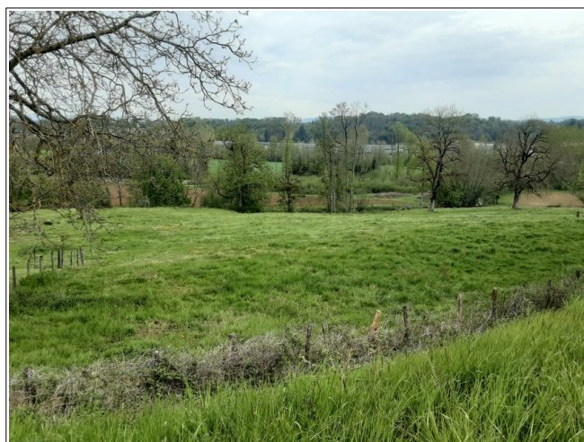
Figure III.10: fort fluage du terrain au lieu-dit Grange-Bègue.
