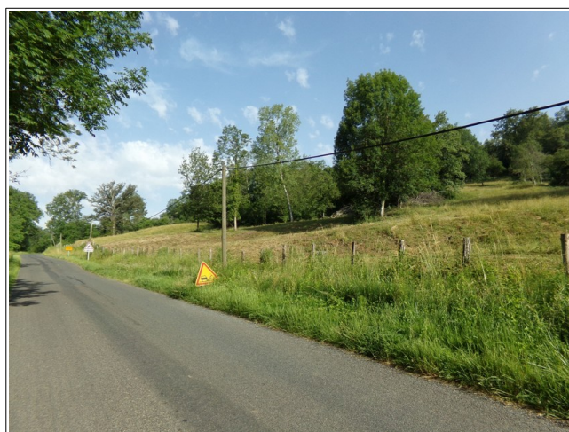
Figure III.59: fluage 200 mètres à l'ouest du hameau de Bublanne à l'amont de la RD 93a (proximité du cimetière).
