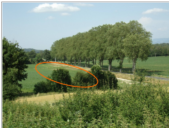
Figure III.75: bordure de la RD 984 inondable au lieu-dit le Colombier / Sous la Côte, au droit du village de Loyes.
