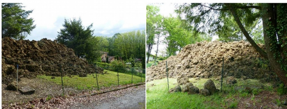
FIGURE 11 : TAS PRINCIPAL STOCKÉ AU SUD DU GLISSEMENT
