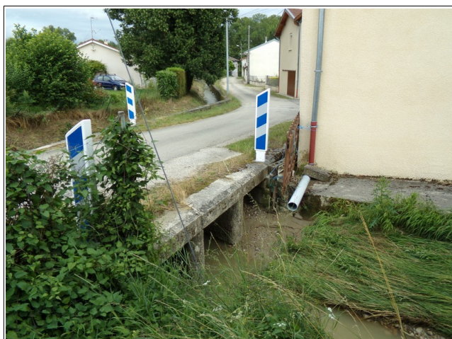
Figure III.64: pont de la rue des Brotteaux.
