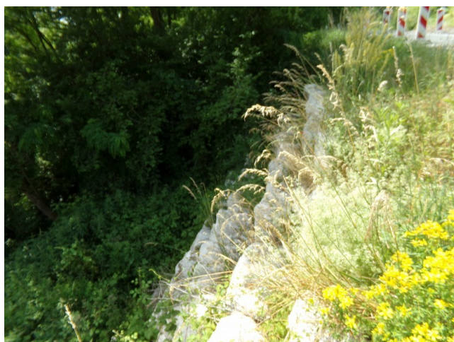
Figure III.60: enrochement du talus aval de la RD93a au droit de Mas-Durand.
