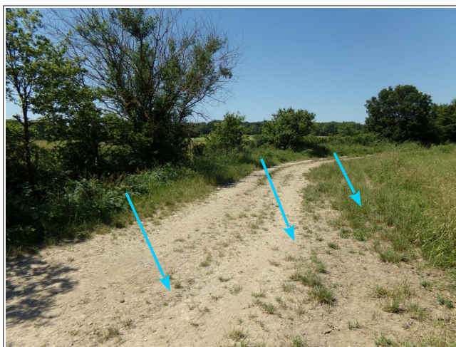
Figure III.2: Bief de Boujon au niveau de la zone agricole du Rosier (vue depuis l'aval). Le ruisseau situé au niveau de la haie peut déborder en rive gauche, sur le chemin et des terrains voisins.
