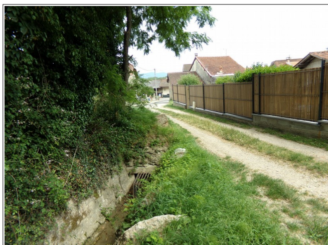
Figure III.47: ruisseau de Charmont à l'entrée de son ouvrage de couverture.
