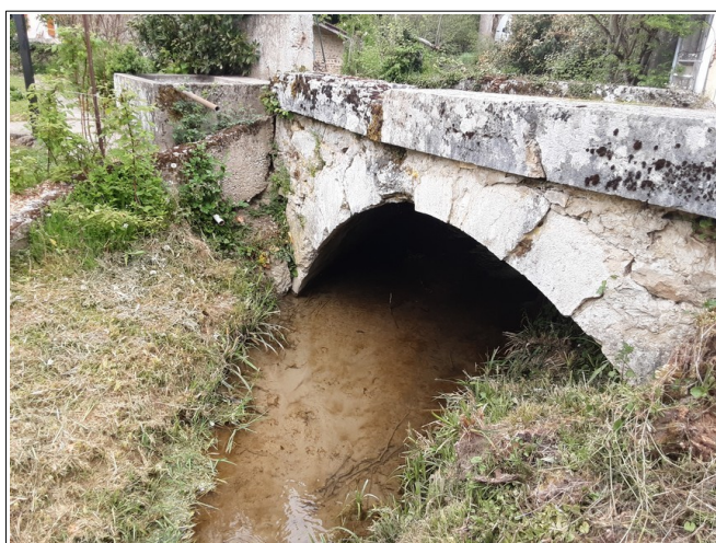
Figure III.42: pont de l'impasse du Lavoir (ouvrage amont à l'entrée du hameau de Bublanne).
