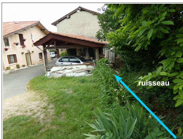
Figure III.49: débouché du ruisseau de Chez le Bret dans le quartier de Gévrieux et entrée du busage amont.
