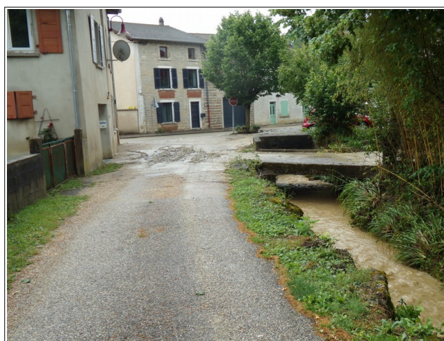
Figure III.43: ponceau et ouvrage de couverture de l'impasse du Lavoir, à l'approche de la RD984.
