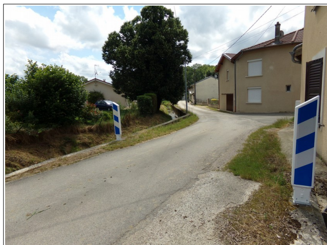
Figure III.65: rue des Brotteaux inondable en rive droite.
