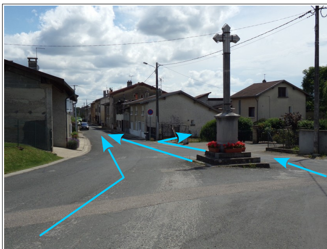
Figure III.69: voirie du village de Loyes potentiellement exposée aux phénomènes de ruissellement (carrefour entre la RD108 et la rue de Crans).
