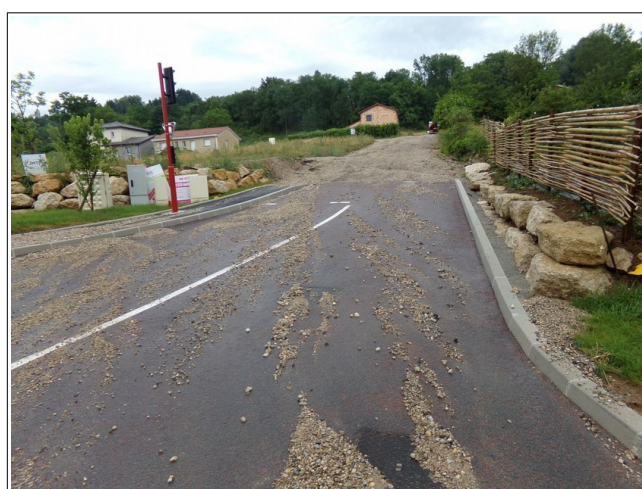
Figure III.32: exemple de ruissellement au pied de la Côtière (secteur les Corrières / le Pollon) suite aux orages de juin 2021.
