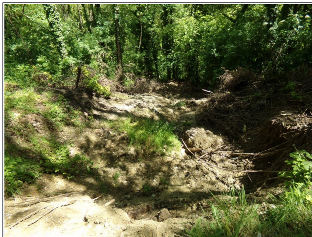
Figure III.38: glissement de terrain superficiel au pied du versant des Corrières.
