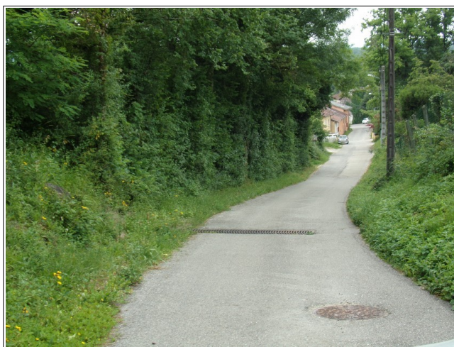
Figure III.51: chemin des Verchères pouvant drainer des écoulements en direction du quartier du Champ (nord du village).
