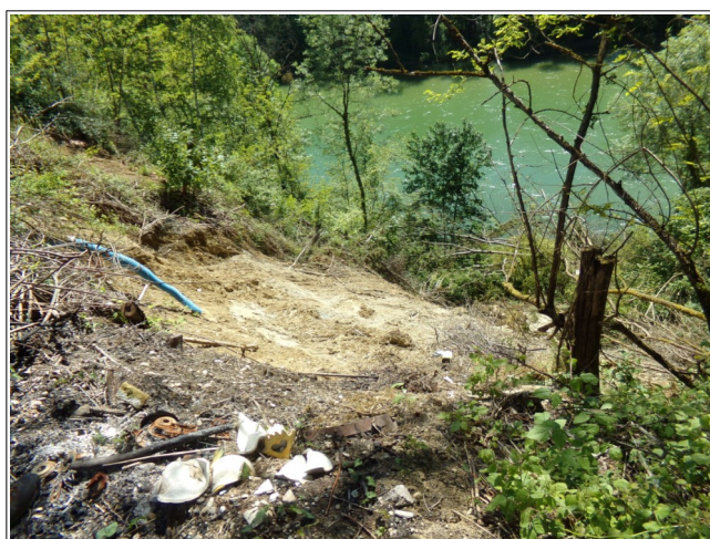
Figure III.29: glissement de terrain superficiel en rive droite de l'Ain (mai 2021).
