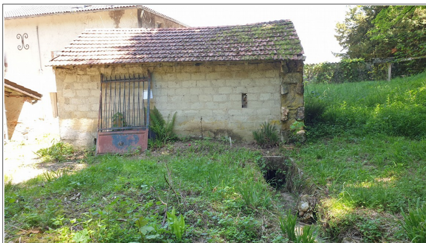
Figure III.13: entrée de la couverture du ruisseau de la Combe du Château de Boissieu.
