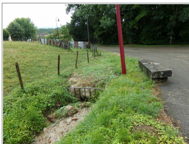
Figure III.45: busage du ruisseau des Vignes-Beguet au droit du cimetière.
