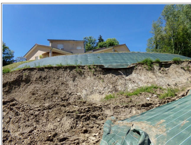
Figure III.36: zone d'arrachement du glissement de terrain de mai 2021 sur la parcelle 403.
