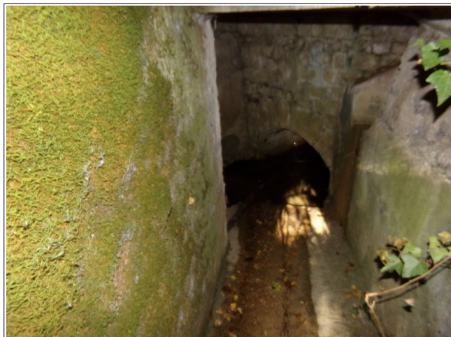
Figure III.16: exemple d'ouvrage étroit et sinueux franchissant la RD984 (embranchement de l'ancien chemin du Château / RD984).
