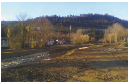
Réhabilitation amont de Lange Montreal
