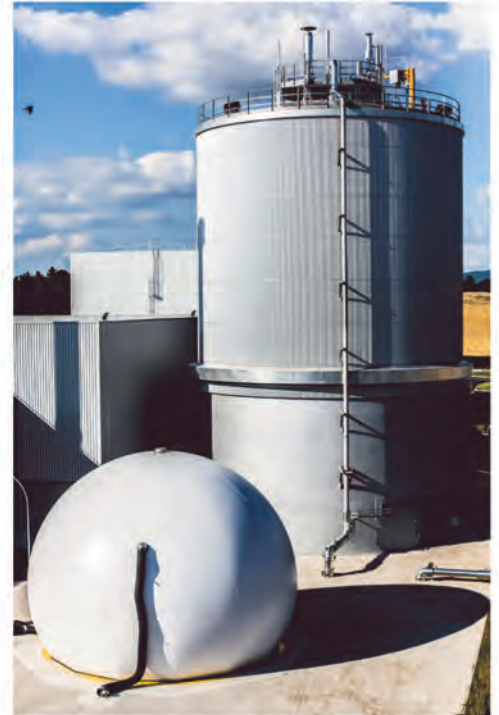
L'usine d'Organom valorise les ordures ménagères (ci-dessus le méthaniseur d'OVADE)
