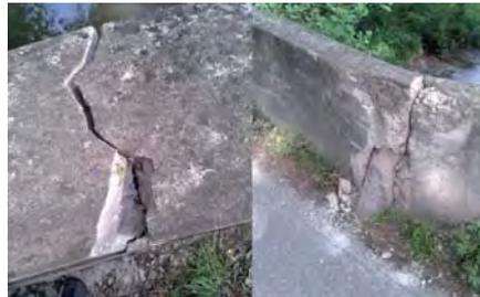
identifier. Nous avons donc, dans un premier temps, interdit le pont aux véhicules, avec mise en sécurité et étalement du parapet qui menaçait de tomber sur la conduite d'assainissement couplée à l'édifice. Après consultation, les travaux ont été réalisés et, après 6 mois de fermeture, le pont a
