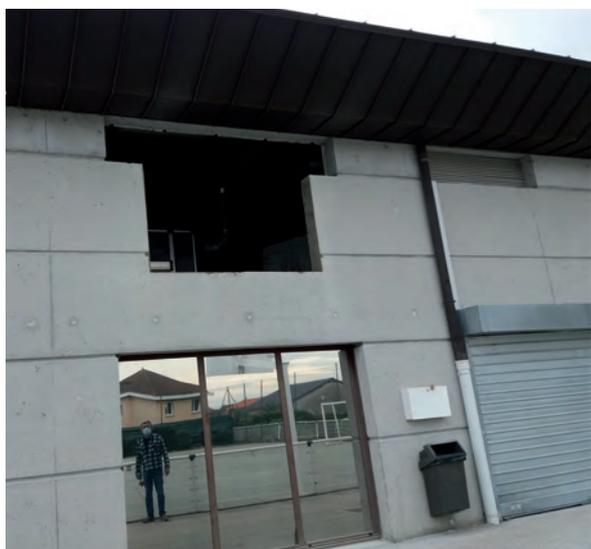
Elle a commencé par agrandir les ouvertures des plateaux techniques, situés dans les combles, afin de démonter et remplacer les CTA (Centrale Traitement d'Air).
