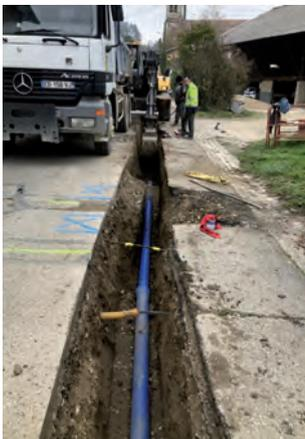
Ces travaux consistaient à remplacer la colonne d'eau, de la rue des Sources jusqu'au réservoir de Fétan et la reprise de la connexion de chaque habitation dont le branchement était encore en plomb. La tranchée a été mutualisée pour partie, avec l'enfouissement d'une ligne électrique, ce qui devrait résoudre les phénomènes de coupures sur le haut de Villieu.
